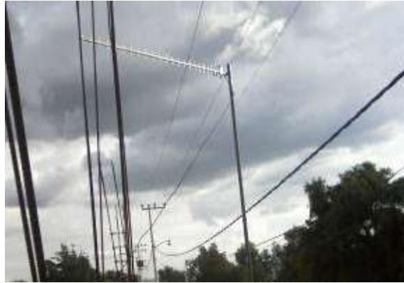
2.1D. ANTENA YAGI NFT-1900-23-10 TNC
